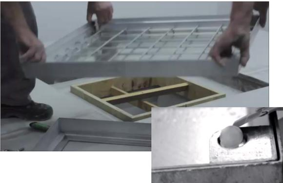
Entfernen Sie die Abdeckkappen und Schrauben, öffnen Sie die Abdeckung mit den Hebeschlüsseln und nehmen Sie die Wanne aus dem Außenrahmen.
