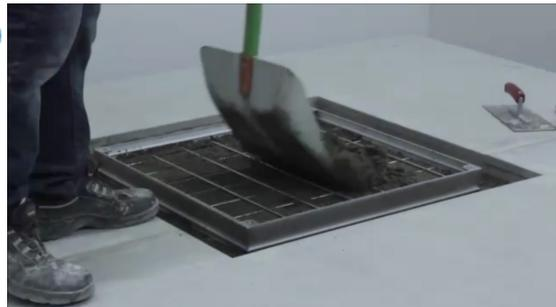
Legen Sie das Bewehrungsgitter in die Wanne, befüllen Sie die Wanne vollständig oder bis zur Unterkante des Endbodenbelags und betonieren Sie die Schachtabdeckung umlaufend vollständig oder bis zur Unterkante des Endbodenbelags ein. Achten Sie darauf, dass das Bewehrungsgitter vollständig mit Beton ummantelt ist und schützen Sie die Schrauben und Ränder vor Betonspritzern.
