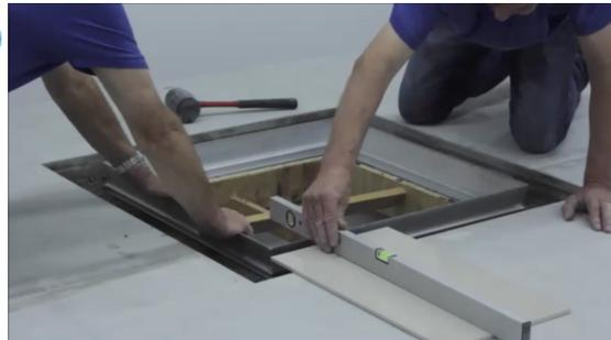
Setzen Sie die Schachtabdeckung in die Ausparung am Boden und richten Sie sie flächenbündig auf die Höhe des Endbodenbelags aus. Es sollten umlaufend mindestens 130 mm Platz zum Ausbetonieren sein.
