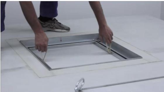
Legen Sie die Brandschutzeinlage in den Außenrahmen. Der Brandschutz ist nur gewährleistet, wenn die Brandschutzeinlage eingelegt und die Schachtabdeckung geschlossen ist. Achtung: Die Brandschutzeinlage ist nicht begehbar!
