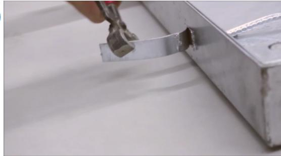
Biegen Sie bei Abdeckungen aus Edelstahl oder verzinktem Stahl die Maueranker so, dass später eine zuverlässige Verankerung im Beton sichergestellt ist.
