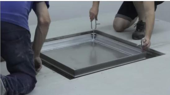
Schließen Sie die Abdeckung und befestigen Sie die Schrauben und Abdeckkappen. Überprüfen Sie nochmals die korrekte Position der Schachtabdeckung.
